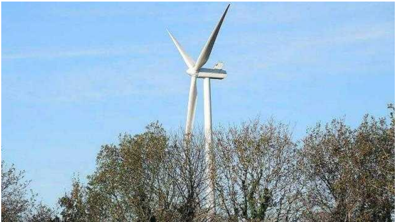
La première éolienne du site de Kergleuziou. | Ouest-France
